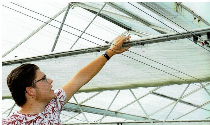
Jimco van Dijk: "Door het dubbele dradenbed blijven de twee schermen strak; de stabilisator zorgt dat ze niet kantelen. De stilstaande lucht werkt net als dubbel glas."
