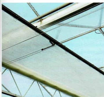
Een dubbel dradenbed houdt de schermen strak; de stabilisator voorkomt kantelen.
